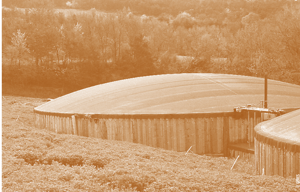
Digesteurs d'une unité de méthanisation
