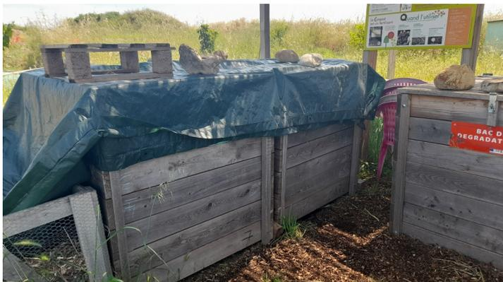
Début juin, les composteurs ont été réparés par les menuisiers de HPM04 : consolidation des parois et isolation avec du FOAMAPAN, évitant ainsi au polystyrène extrudé en place de diffuser des particules nocives dans les composts, ceci dû à la présence de petits rongeurs.
